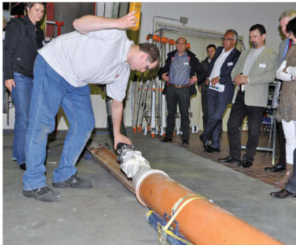
Der HSR-UV (Hutprofil-Sanierungsroboter) der Firma Ulrich Rotte Anlagenbau aus Oberntudorf findet Risse und Schäden im Kanal, die er zum größten Teil auch vor Ort reparieren kann. So vermeidet der Grundstückbesitzer und die -besitzerin eine aufwändige Reparatur mit Schaufelbagger.
